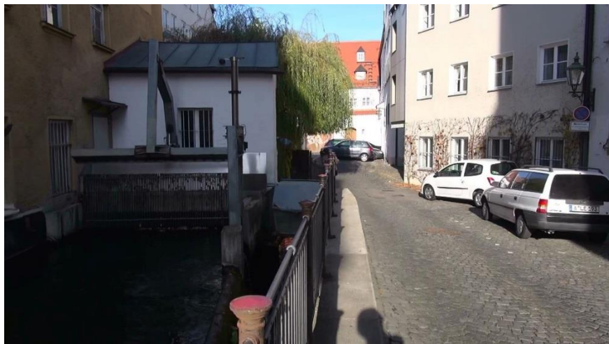
▲ドイツ Augsburg の中心部にある小水力発電施設 (撮影時期 2011年12月)
